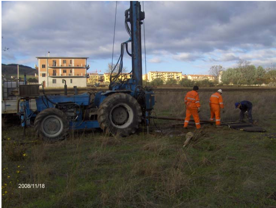
Figura 5: Esecuzione del sondaggio S33
