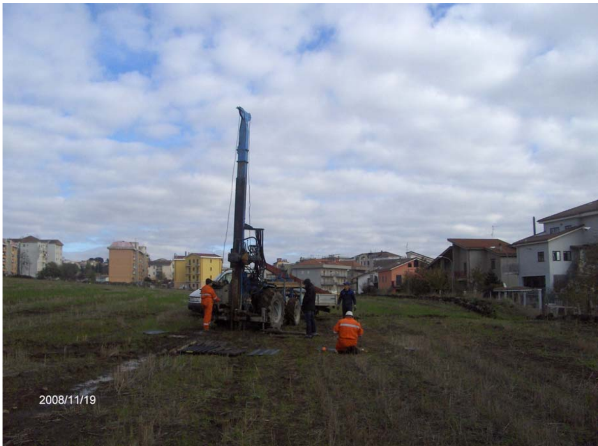
Figura 8: Esecuzione del sondaggio S34
