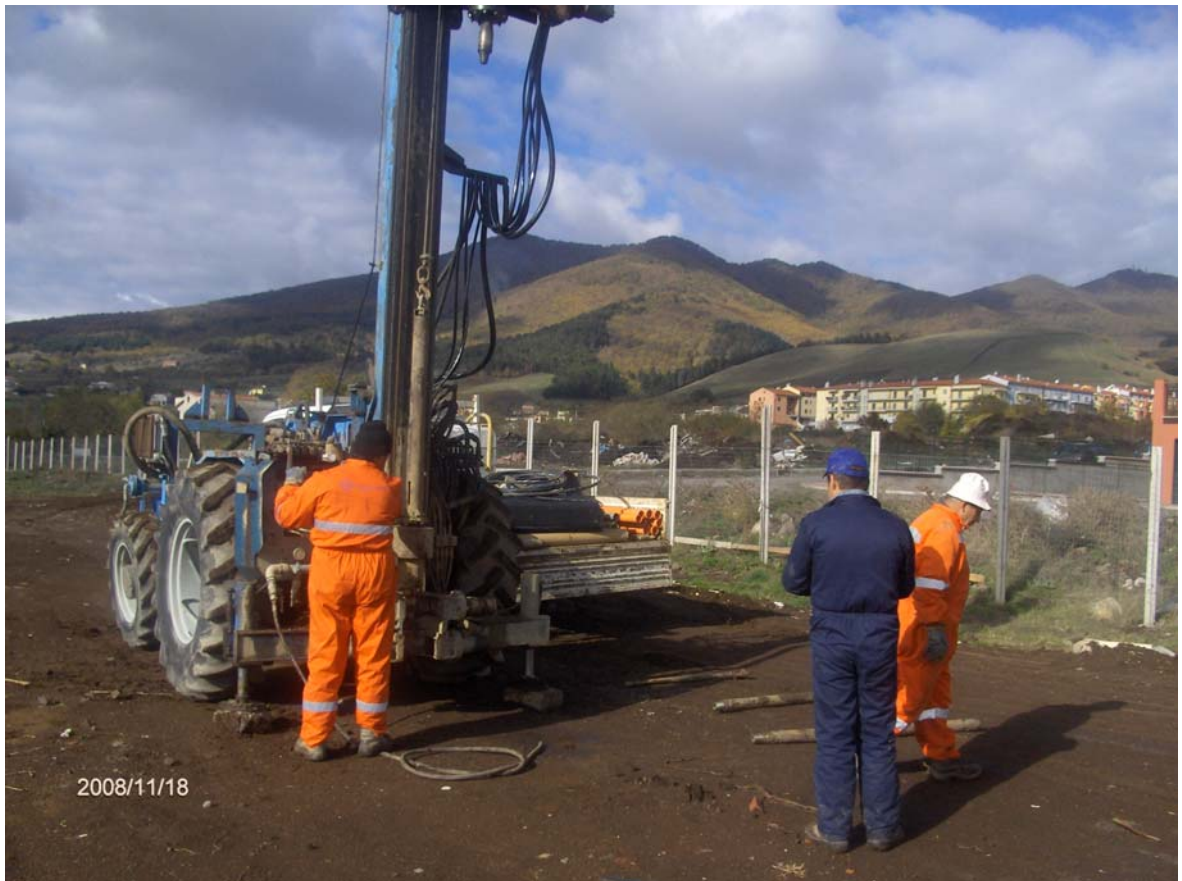
Figura 1: esecuzione del sondaggio S32
